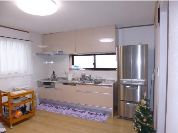
工事後 DK キッチンの新設
